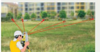
使用该程序可以完成碎部坐标的采集以及角度距离等原始数据的存储,可以使用多达5个已知点进行定向。
